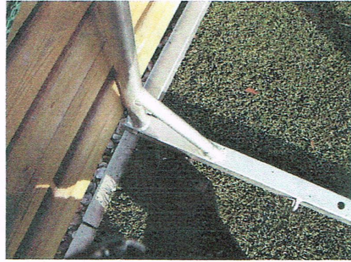
branka na levé straně není jištěna proti převrácení
