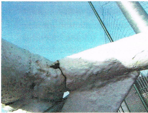
prasklé sváry s korozi
