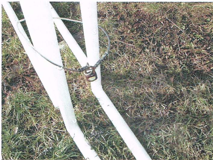
nedostatečné zajištění branek
